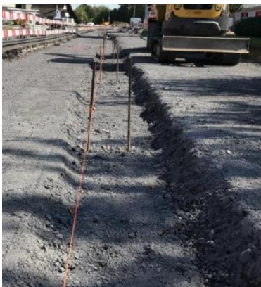
Absteckungen (Eisen einschlagen) problemlos möglich / exakter, standfester Aushub, schmutz- und staubfrei
