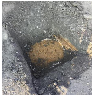
Ruvido-Aushub (0-45S) problemlos möglich. Es entstehen Sondagen mit steilen / stabilen Grabenwänden (hohe Effizienz). Grösstkorn = 63mm bei Ruvido 0/45 und 0/45S
